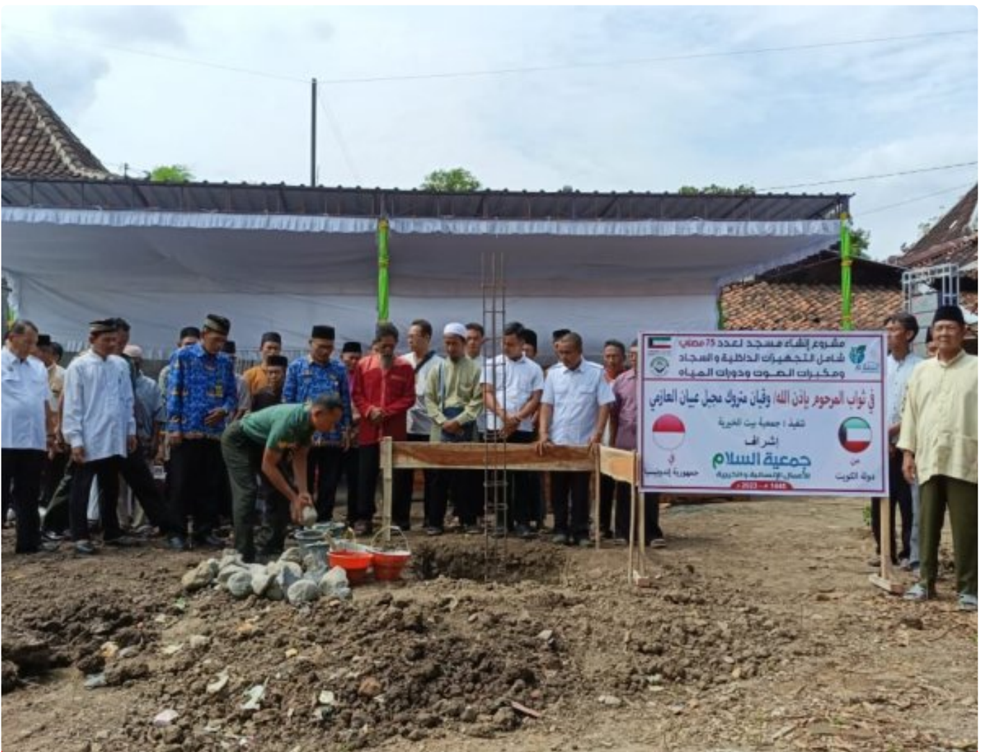
Bati Tuud Koramil Karangdowo Hadiri Peletakan Batu Pertama Pembangunan Masjid
